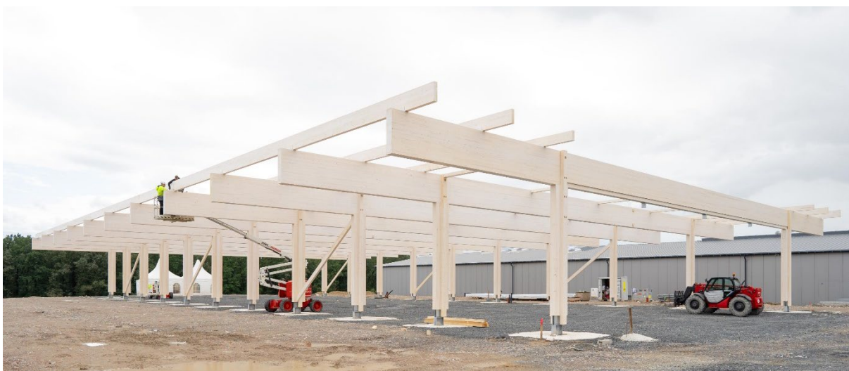
Vue de chantier, montant clairement la trame structurelle en BLC
