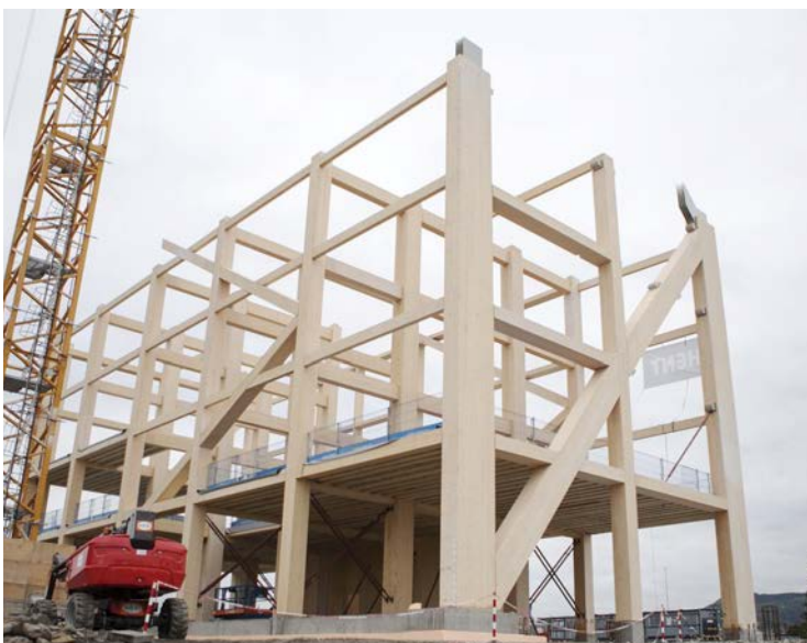
Structure porteuse d'ensemble
