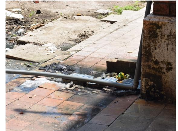
Problème d'humidité à cause des canalisations mises en place.
