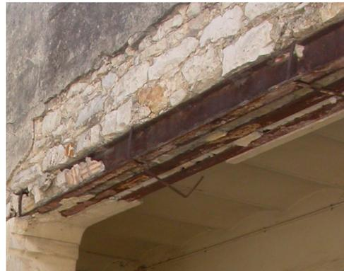
Problème de structure : poutres rouillées à cause de l'humidité.
