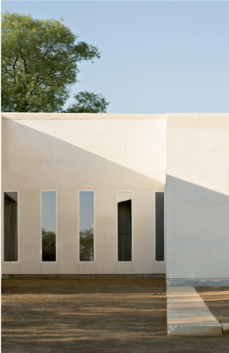
Photo de détail des menuiseries du patio
