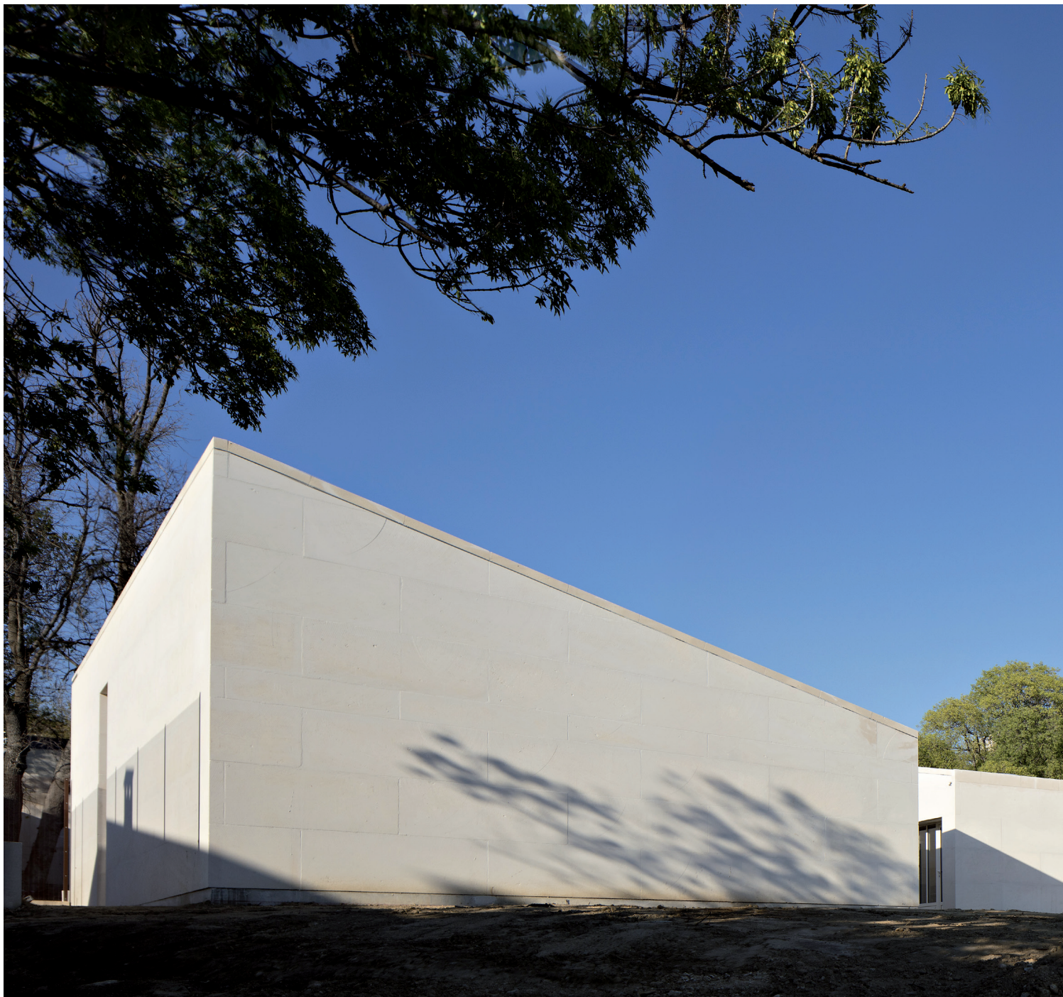
Vue de la construction depuis la rue qui le borde à l'Ouest.
