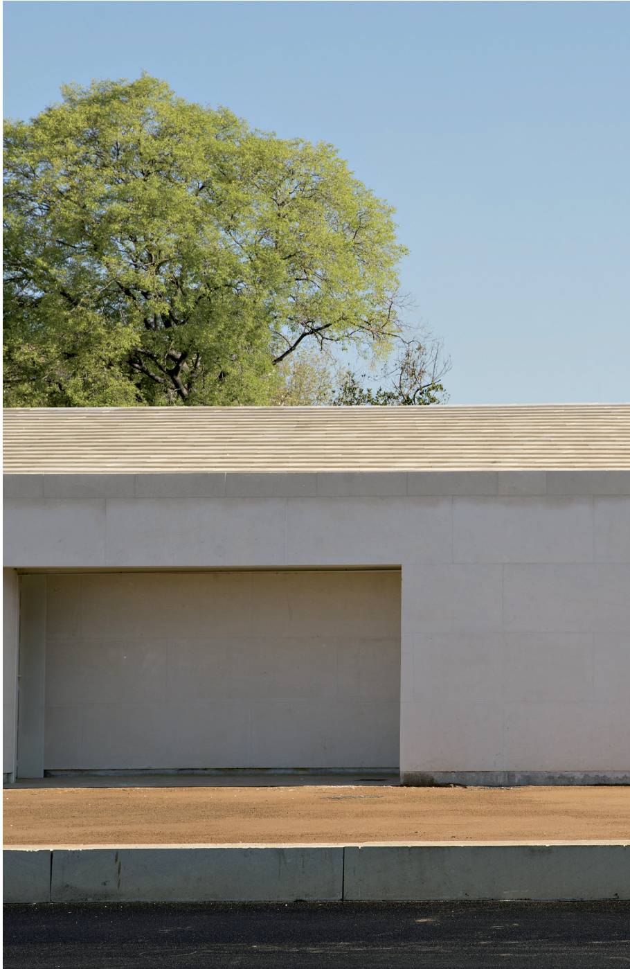
Vue d'un détail de la toiture
