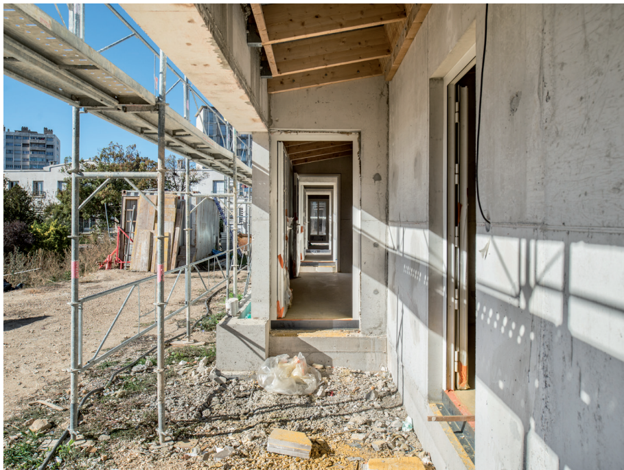
Vue des circulations de l'EPC pendant le chantier
