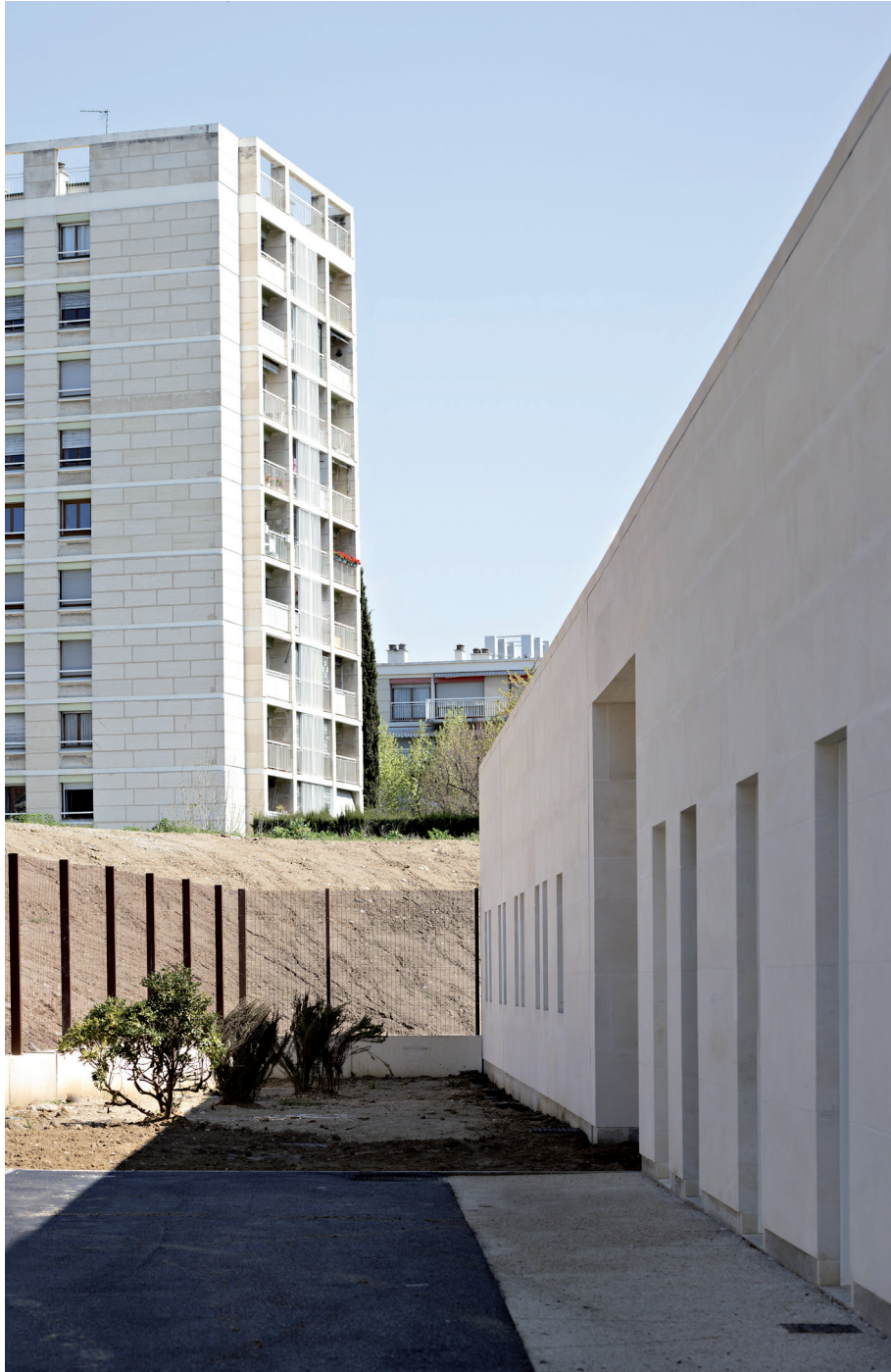
Vue de la façade Nord.
