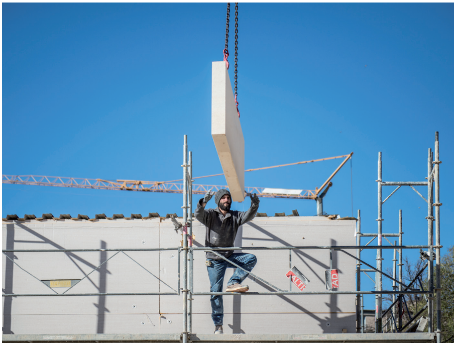
Vue de la mise œuvre de la pierre d'Estailade sur le chantier de l'EPC.
