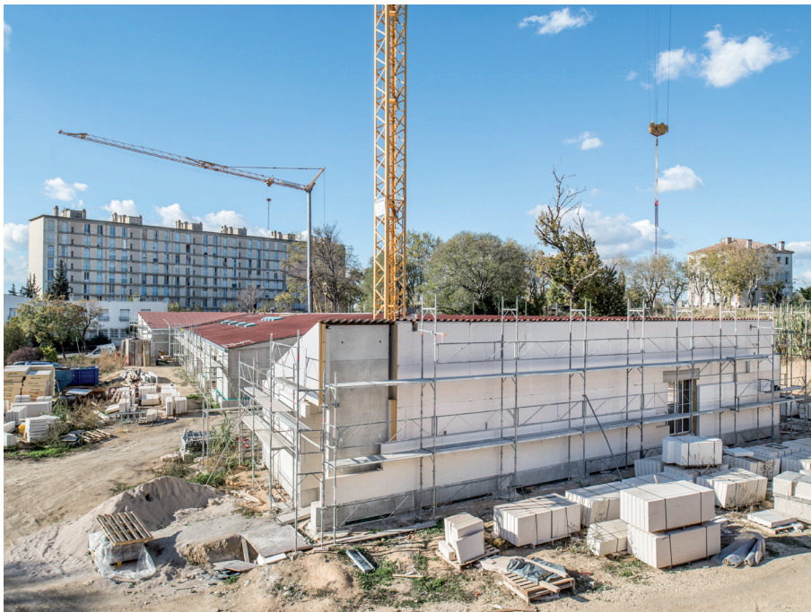
Vue de l'EPC pendant le chantier
