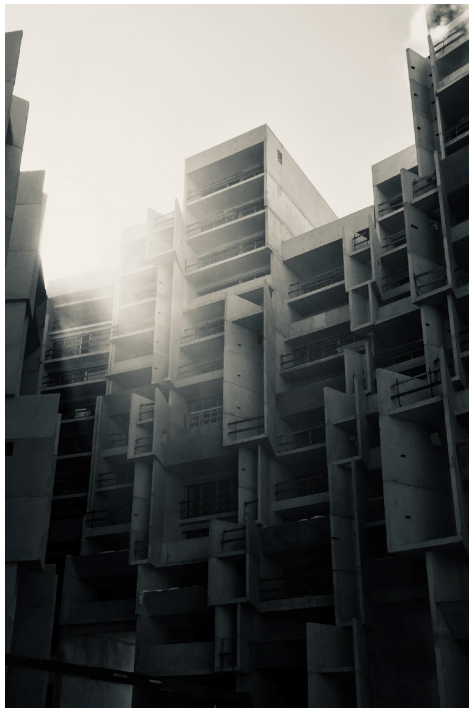
visite de chantier - 3A
