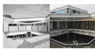
08 Vue d'un patio du dernier étage, disparition des panneaux formant le studio, dégradations des revêtements de sol.
