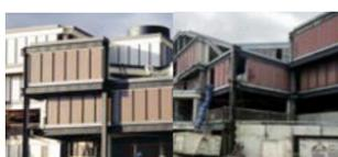
04 Vue de l'école au Nord-Ouest, dégradations des panneaux métalliques.
