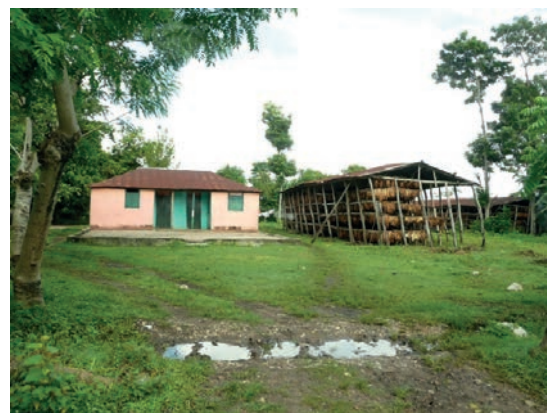
Déformation des ossatures ; juxtaposition de deux constructions vernaculaires en Haïti : Plaine des Cailles (2005), le séchoir à tabac possède les capacités de se déformer suivant des parallélogrammes, les poteaux de fonds fichés dans la terre dissipent l'énergie lors des déplacements.
