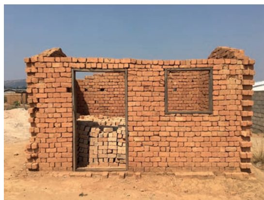
Chantier lent de construction informelle à partir de la technique la plus ordinaire de maçonnerie brique et de cadres de baies en pierre de bois fins et de bonne qualité. Périphérie d'Antananarivo, Madagascar (2019). Certains modes constructifs comme celui-ci proposent des rapports entre masse et raideurs beaucoup plus faibles que d'autres. Les raideurs (ou souplesses) de ces murs de briques maçonnées sur la base de lits de mortier de faible épaisseur est pour ainsi en correspondances directes avec le coefficient de frottement terre faiblement cuite/ terre crue, très proche d'un mur de maçonnerie monté à sec fortement dissipateur.
