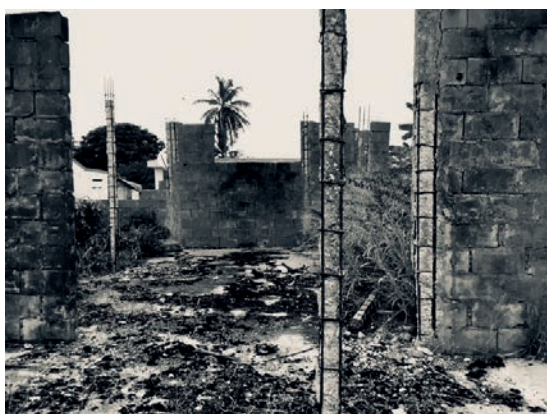
Poteaux béton en bord de mer
