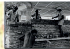
Élévation d'un mur en BTC par des ouvriers
