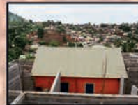
Extension en parpaing d'une « case SIM », 2004
