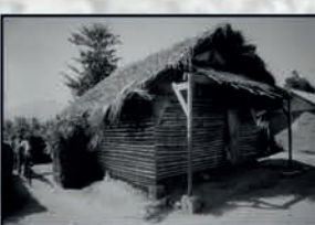
TETRO : structure en treillis de bois sans remplissage
