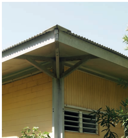
Ill. 5 : Dispositifs architecturaux du système EXN : « nacos », nœud d'assemblage cruciforme et mixité des matériaux, Mairie-Annexe de La Saline-les-Bains (2019) © Manon Scotto
