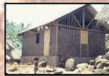
Le remplissage des parois est ici réalisé avec des pierres et du grillage.
