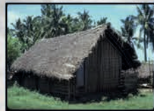
EANDRÁKA : structure en châssis sur laquelle sont installés des panneaux de nervures (ou rachs) de raphia entrecroisés, formant un « grillage » à l'extérieur et associé à un
