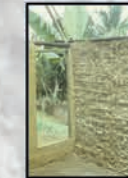
A gauche, une paroi avec porte finalisée. A droite, le treillis avec boue de terre et de paille.
