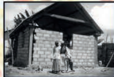
Remplissage en parpaings
