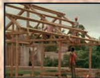
Ossature en bois
