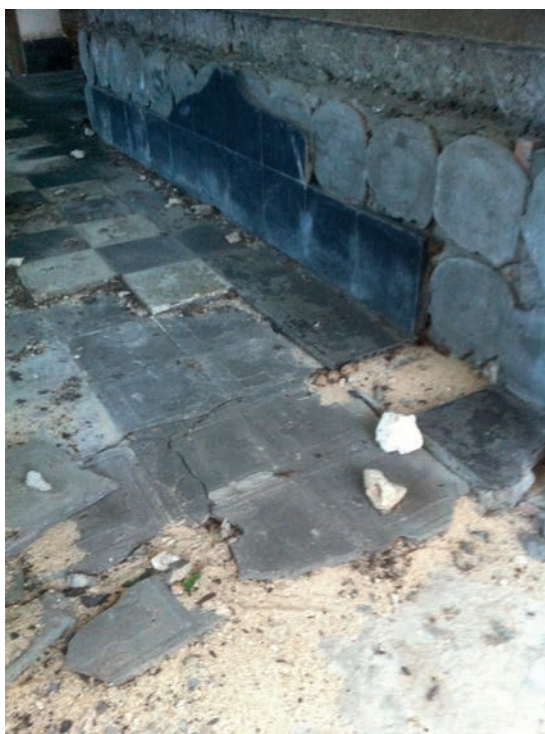
Hôtel de ville de Port Louis sur Grande-Terre en Guadeloupe (2019), les sols en céramique sont posés sur des lits de sables, cette masse est indépendante vis-à-vis de l'ossature primaire du bâtiment.
