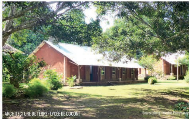
ARCHITECTURE DE TERRE - LYCÉE DE COCONI
