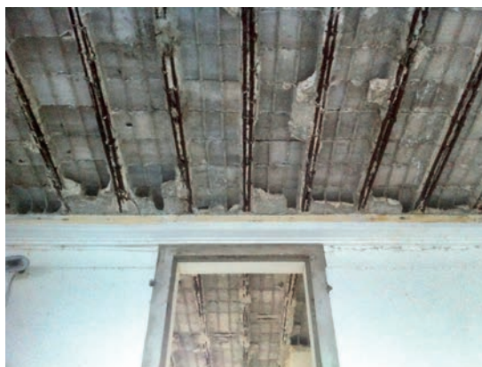
Armatures apparentes
