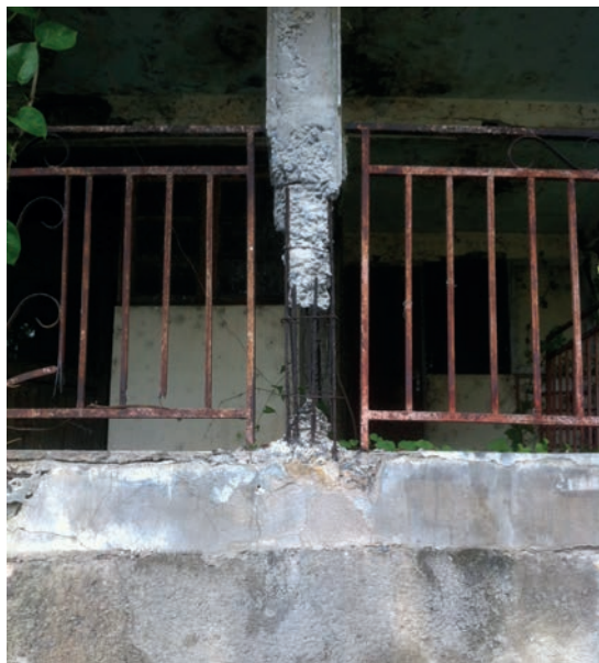
Construction ordinaire contemporaine
