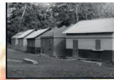
« Cases SIM » en BTC, à différents stades de construction
