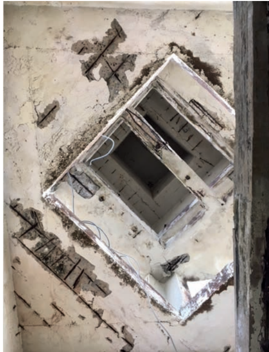
Sous face de dalle
