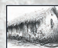
RISE : construction en pierre (essentiellement basaltique) et chaux (composée de corail et de sable).
