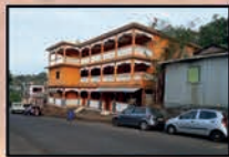
Les balustrades de chaque étage sont différentes. A noter le travail des linteaux. La maison à droite est réalisée en tôle. M'baopé, 2019
