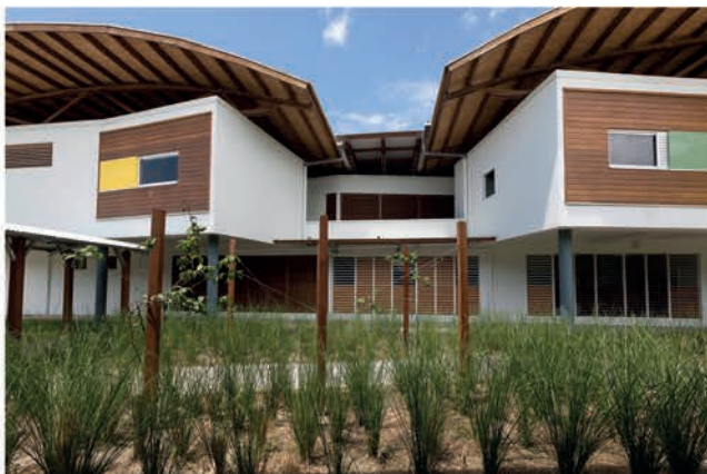
LES FAÇADES NORD ET SUD SONT PROTÉGÉES PAR LES GRANDS DÉBORDS DE TOITURE TANDIS QUE LES PIGNONS EST ET OUEST REÇOIVENT UNE FAÇADE EN BARDAGE BOIS ISOLÉE AVEC PROTECTIONS SOLAIRES MOBILES. L'OMNIPRÉSENCE DE VÉGÉTAL PERMET D'AUGMENTER L'ALBÉDO DU SOL.
