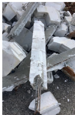
Protection des bétons : Chantier de démolition d'un frigo industriel dans le Nord Isère (2019), les ossatures en béton armé sont incluses au mur par l'intermédiaire du coffrage perdu qui fait office d'isolation thermique partielle. La protection des bétons en usage dans le long terme est réalisée par le béton cellulaire, poreux au titre de la régulation climatique et hydrologique.
