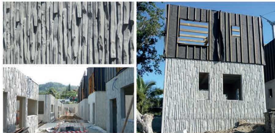
SOCLE EN BÉTON MATRICÉ EN CHANTIER >
