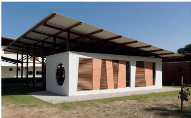
CHAQUE PARTIE ET CHAQUE ORIENTATION DU BÂTIMENT DISPOSE D'UN TRAITEMENT SPÉCIFIQUE SELON LES USAGES ET LES PÉRIODES D'OCCUPATION, PARTICIPANT AINSI À LA DIVERSITÉ D'AMBIANCES ARCHITECTURALES DE L'ENSEMBLE. LA VENTILATION TRAVERSANTE EST SYSTÉMATIQUEMENT PRIVILÉGIÉE.
