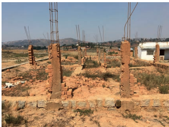
Démontage de la construction ordinaire
