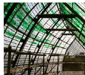
Un toit en plastique
