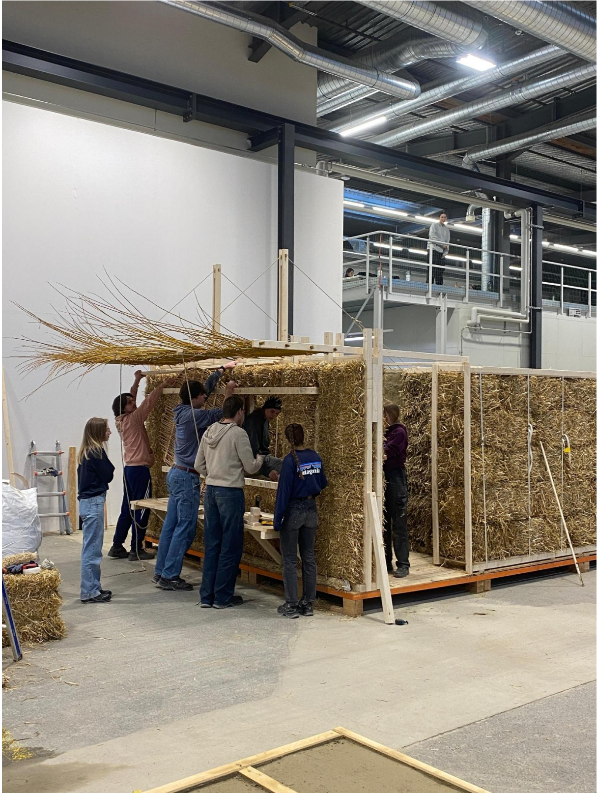
Figure 17 : Montage d'un des pavillons
