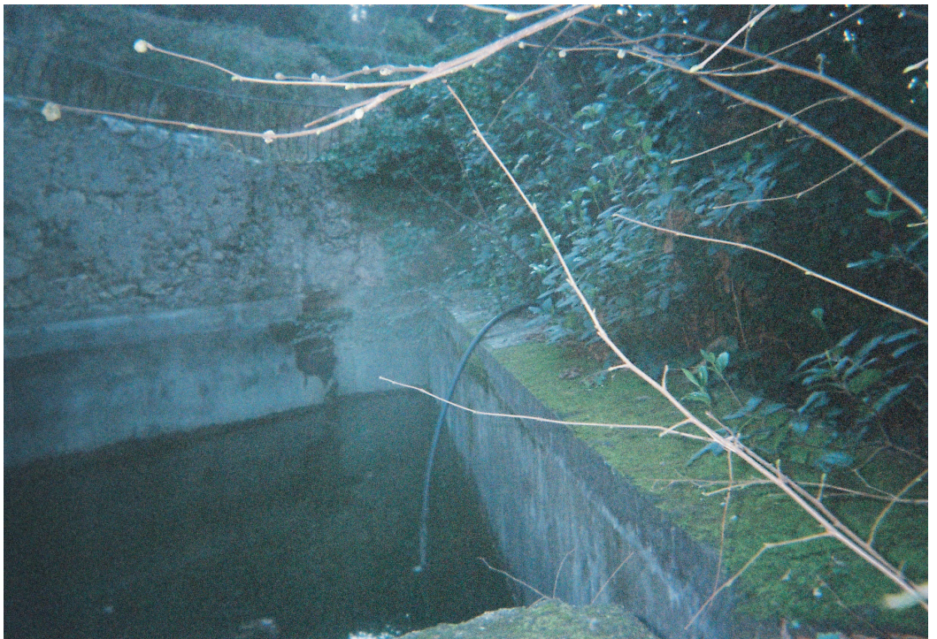
↓ Bassin de stockage d'eau à l'abandon localisé en haut du rocher
