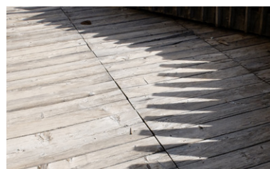
114/ Photographie des garde-corps et terrasses en bois
