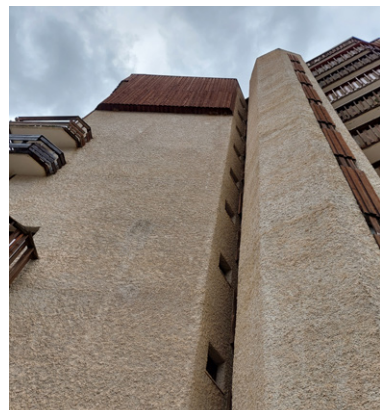
111/ Photographie de la structure béton, recouverte d'un enduit crépis
