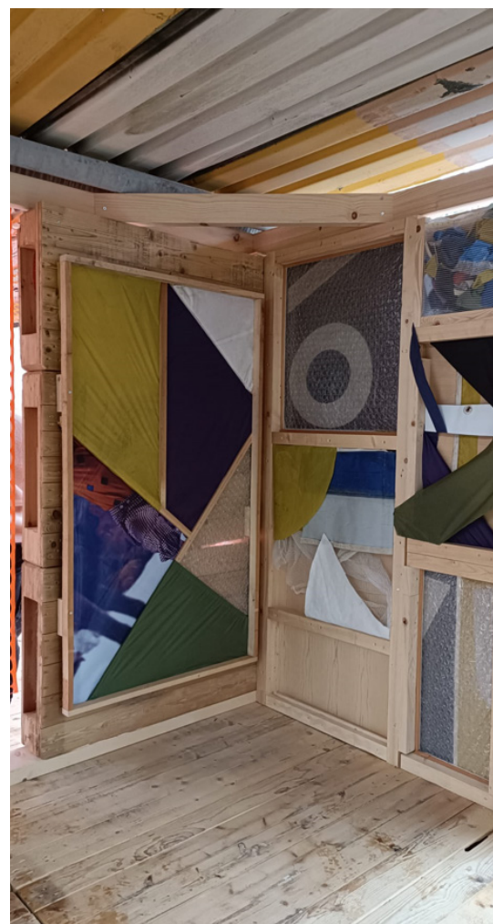
Revêtement intérieur en baches de camion
