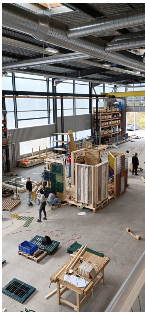
Construction du module
