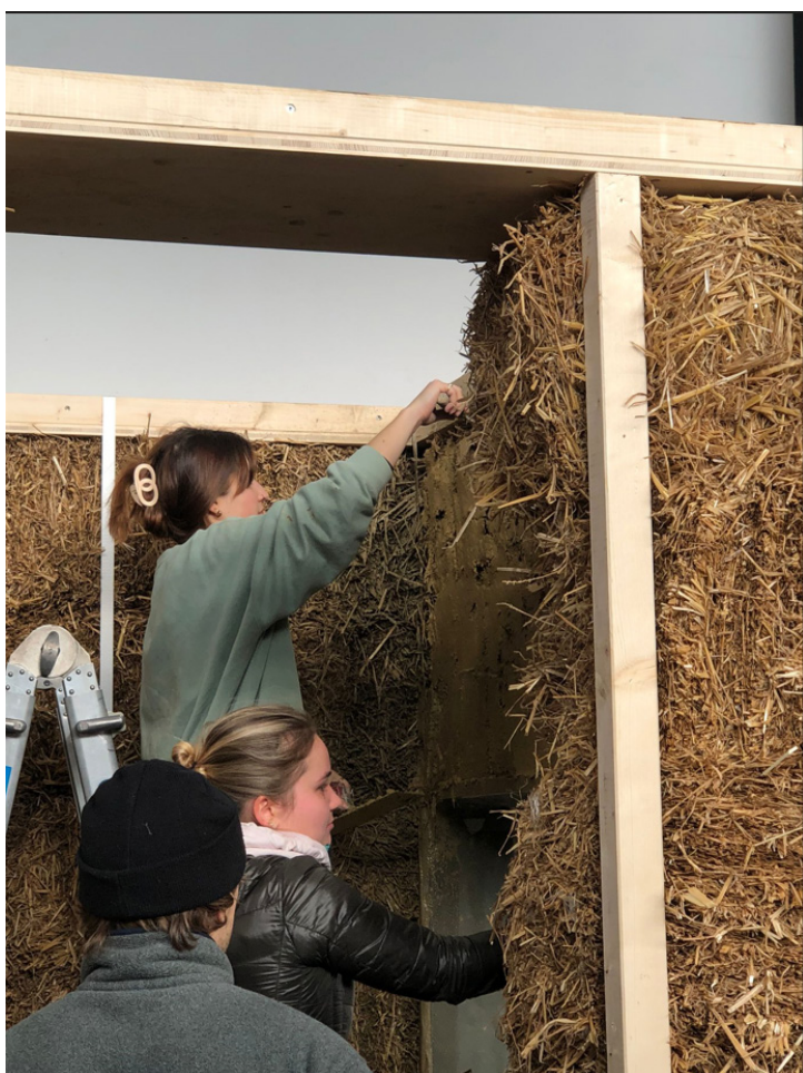
Moi en train de mettre du crépi à l'intérieur du module
