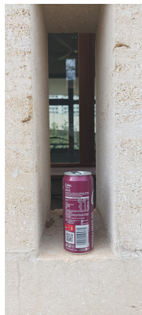
Fig. 13. Un immeuble déjà un peu meuble. Photo : DL
