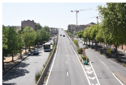
Fig. 7, 8, 9, et 10. Le quartier en cours de réhabilitation. Photos : Chimène Denneulin.
