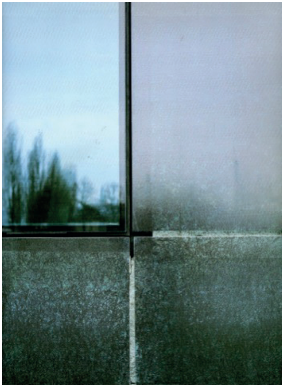
Herzog & de Meuron, Centre sportif Pfaffenholz, Saint Louis, France
