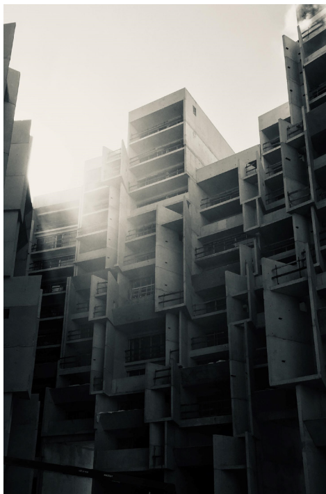
visite de chantier - 3A
