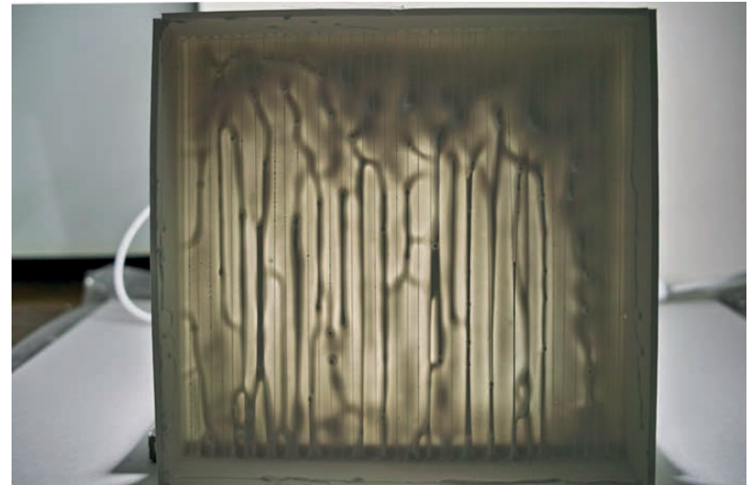
Remontée capillaire sur plâtre
