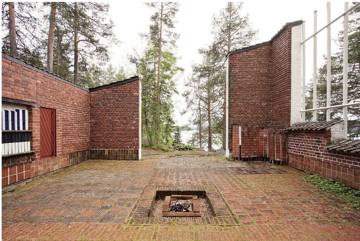
Alvar Aalto, maison à Muuratsalo, 1953, Finlande.
