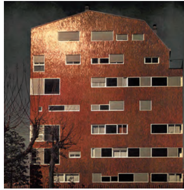
fig.8 Architectes Mario Asnago et Claudio Vender Edificio per abitazioni e uffici (1953) Milano, Via Faruffini 6 Source Lombardia Beni Culturali Archivio Asnago Vender Unità: AV127
