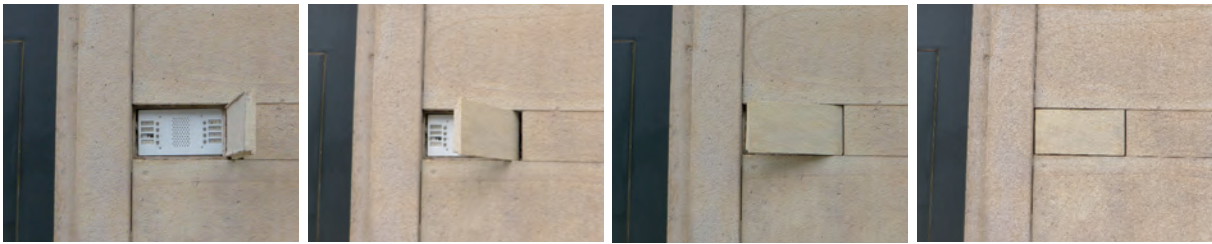
fig. 12 Architecte Luigi Caccia Dominioni Casa Pirelli (1962-1964) Milano, Via Cavalieri del Santo Sepolcro 6 Photographie de l'auteur
