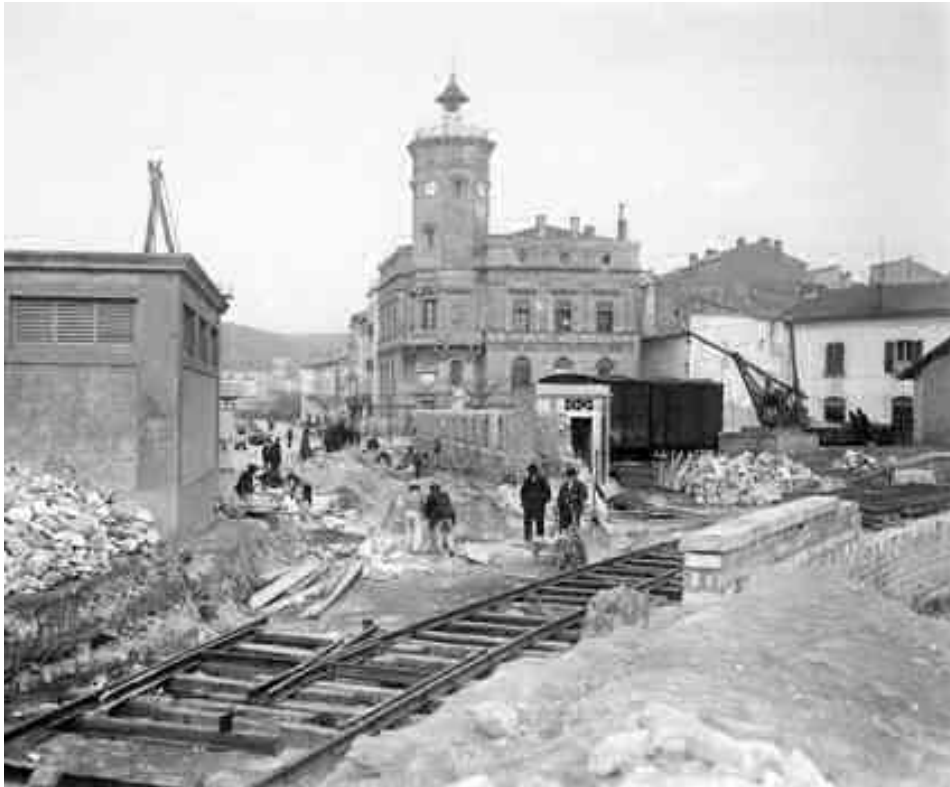
Construction de la voie ferrée reliant la Gare aux Chantiers navals (1916)
