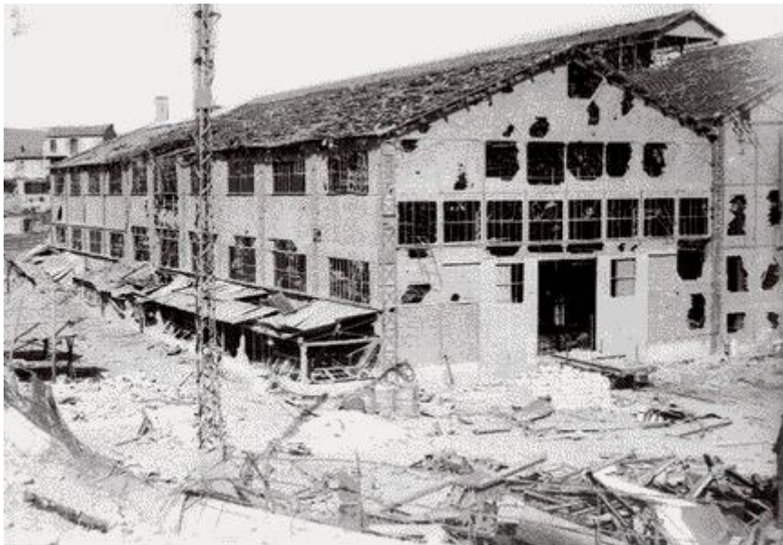
Démolition du Chantier Naval par les allemands en 1944
