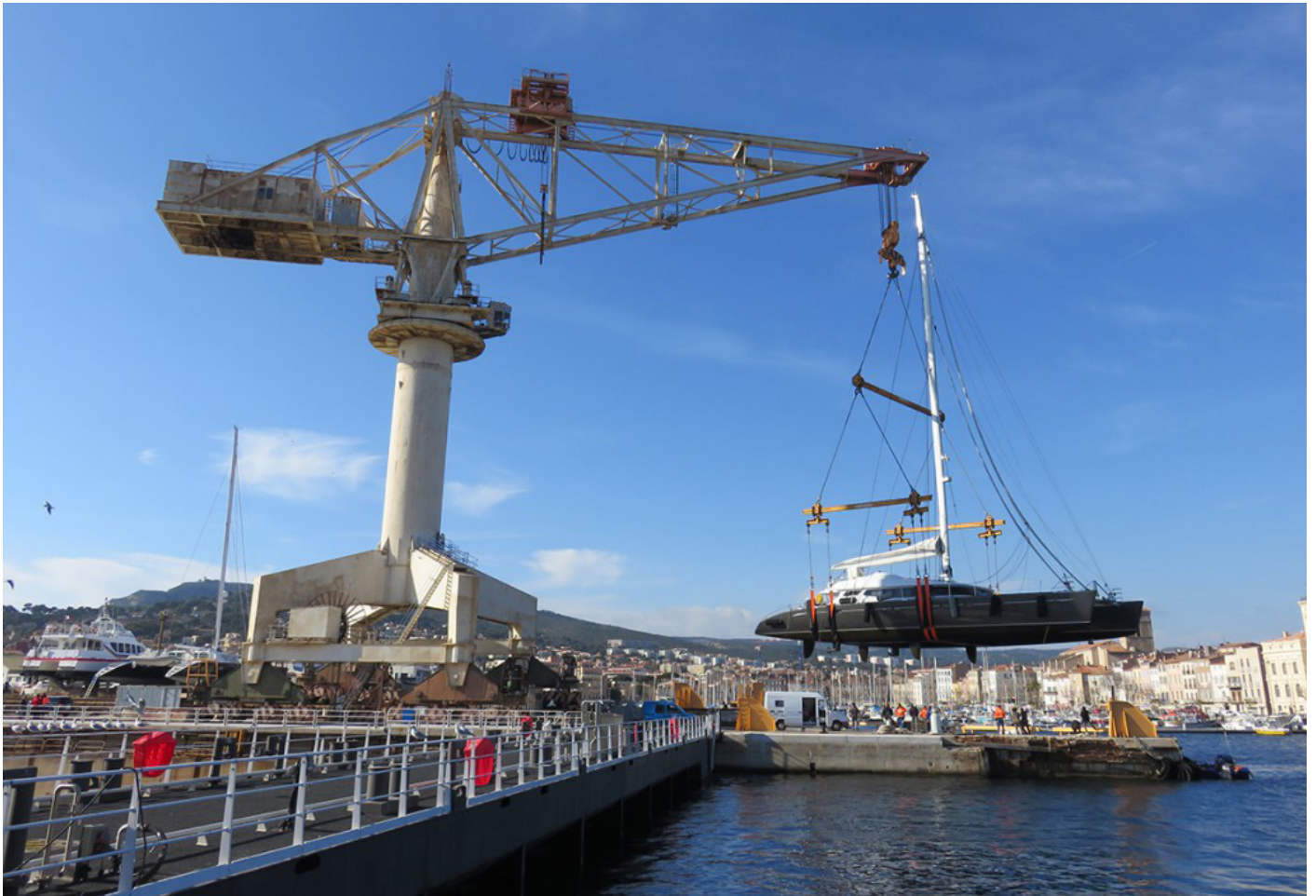
Une grue en fonctionnement (Classicworks)
