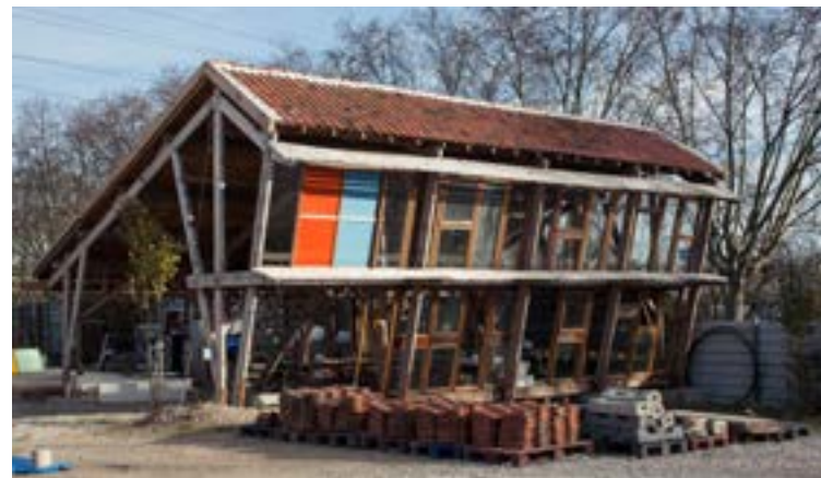
Actlab, la base vie, réalisée en réemploi.
