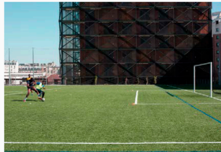
21 - Toit du stade Jules-Ladoumègue. Reconstruction des équipements sportifs, Paris 19e, 2014. DFA |Dietmar Feichtinger Architectes; Empreinte, bureau de paysage; Ville de Paris, maître d'ouvrage.
